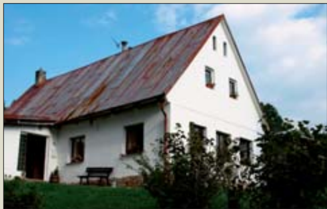
Původní stav rodinného domu
