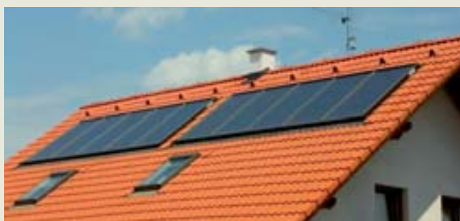
Obr. Pro solární systémy využívané i k přitápění se u rodinných domků používá kolektorová plocha 12 až 20 m 2 .
