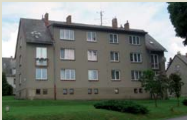
Původní stav bytového domu
