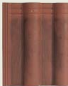
Povrch tradiční střešní tašky: silně znečištěný
