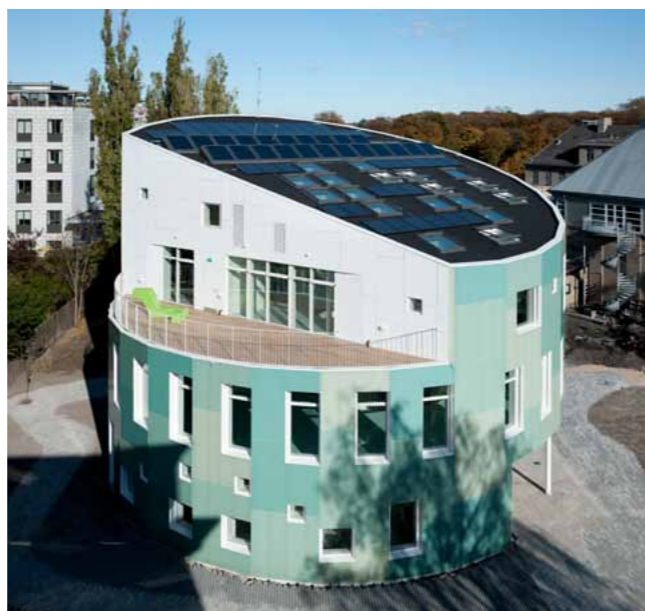
První bezemisní veřejná budova v Dánsku. Zelený maják (Green Lighthouse), Dánsko
